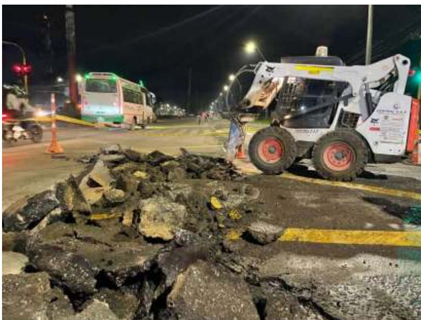
Figura 16 Demolición de carpeta asfáltica
