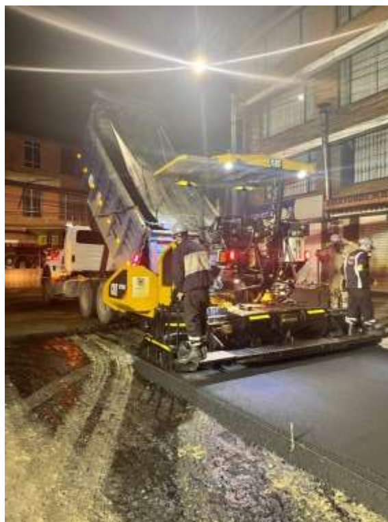
Figura 19 Instalación mezcla asfáltica
