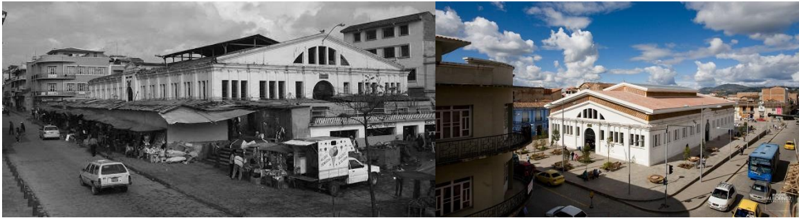
Imagen 53: Antes y después mercado cuenca, Ecuador. Fuente: Mercado, Archdaily
