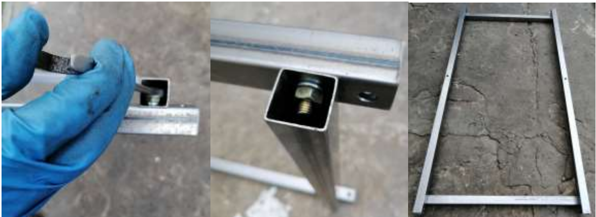
Figura 21 Proceso de ensamble de estructura y ajuste de perfiles
