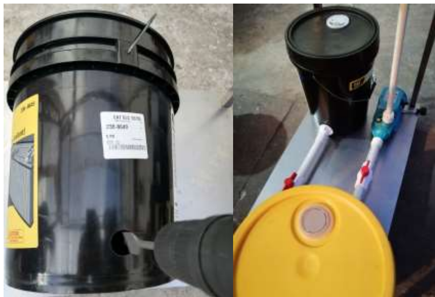
Figura 24. Instalación de tanques y motobombas
