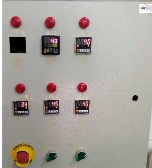
Figura 3 – Panel de indicación de la temperatura de los procesos térmicos
