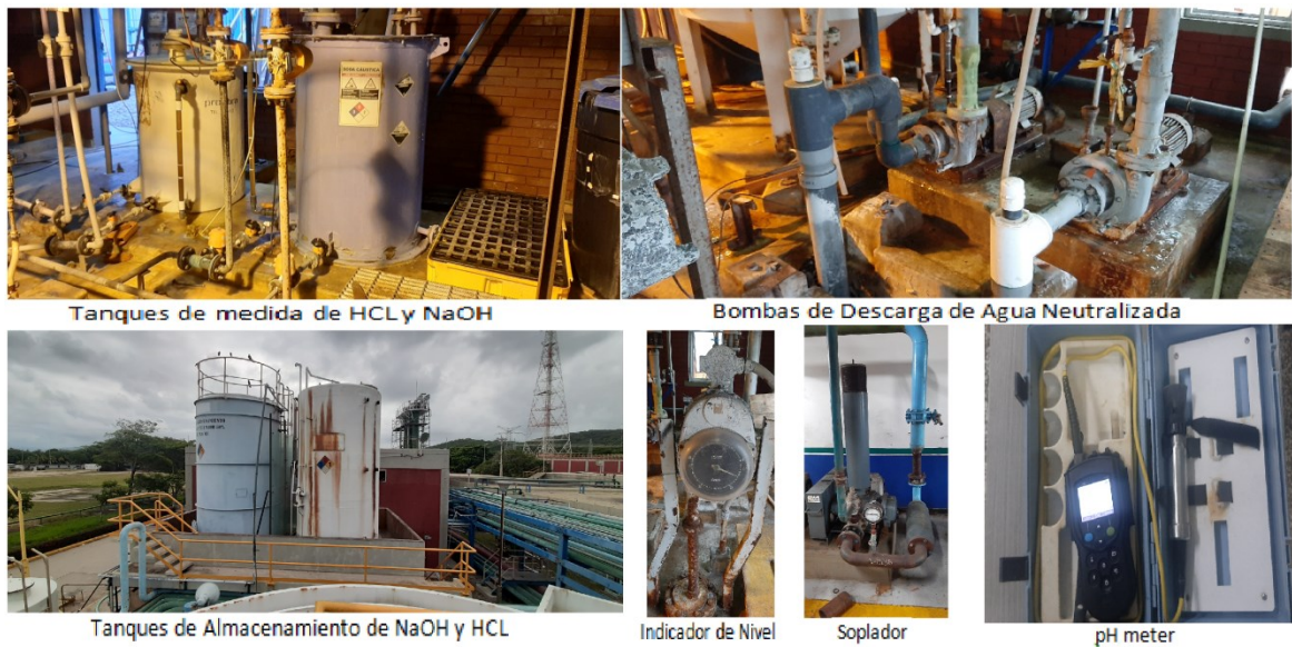
Figura 3.2 Estado de los Equipos.
