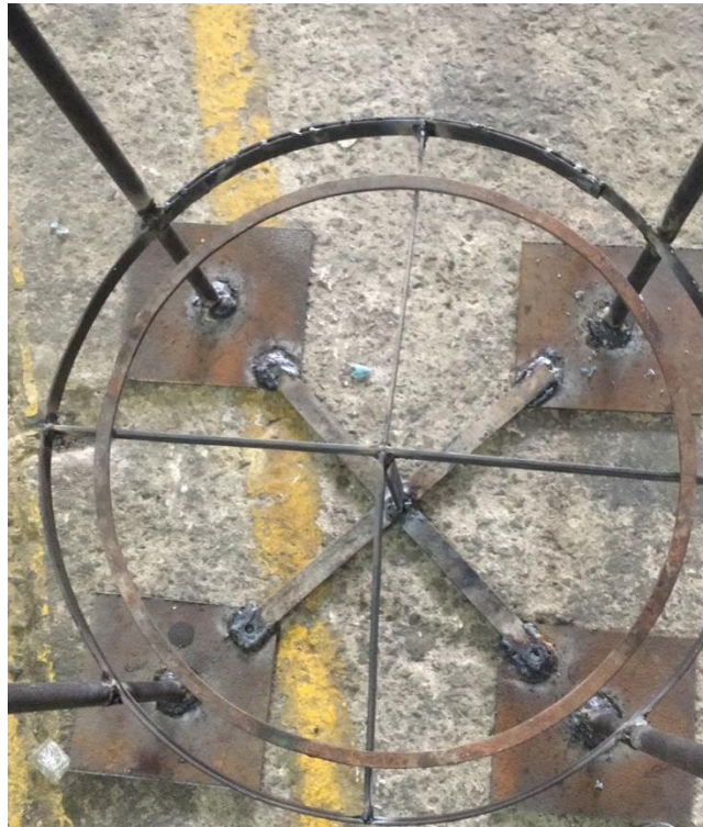
Figura 22. Soporte tanque de Almacenamiento (Autores)
