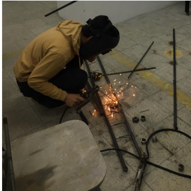
Figura 23. Construcción brazos para colectores (Autores)
