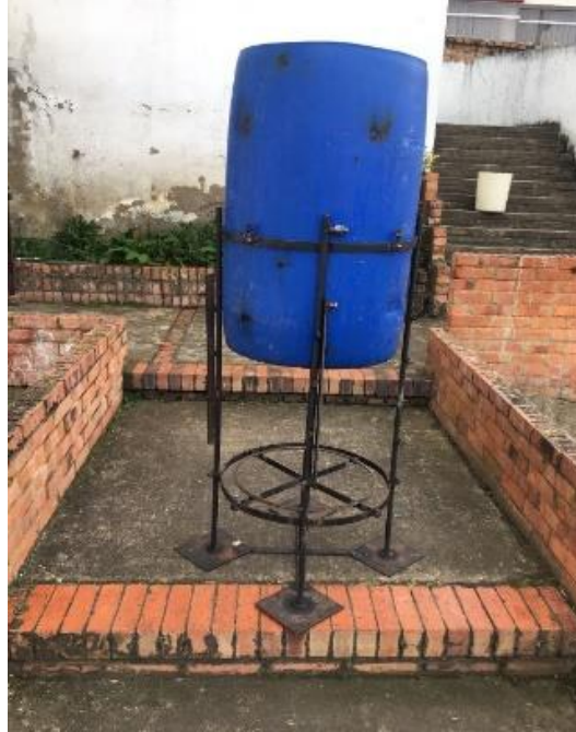
Figura 26. Instalación tanque de almacenamiento en estructura base (Autores)
