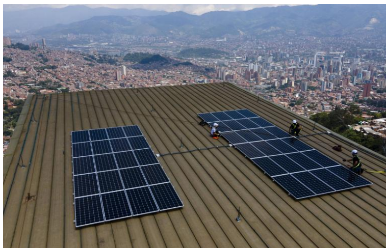
Fig. 7 Instalación de paneles solares en Medellín
