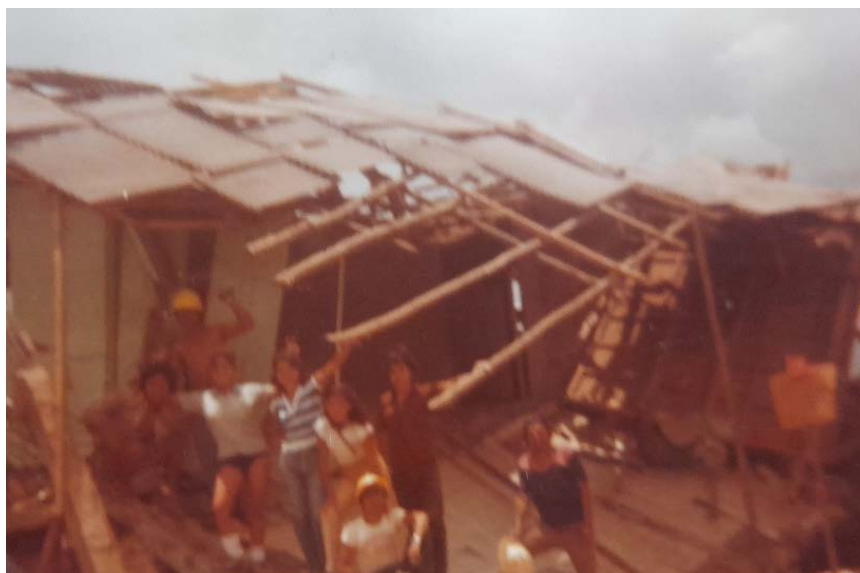
Casa de habitación de la familia Chaves Martínez destruida en el terremoto de 1983 en Popayán.
