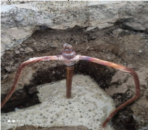
Figura 12. Hidrogel, Sistema puesta tierra.
