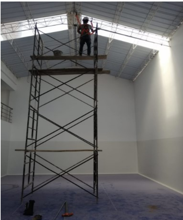
➤ Figura 9. Instalación de tubería emt, circuitos ramales
