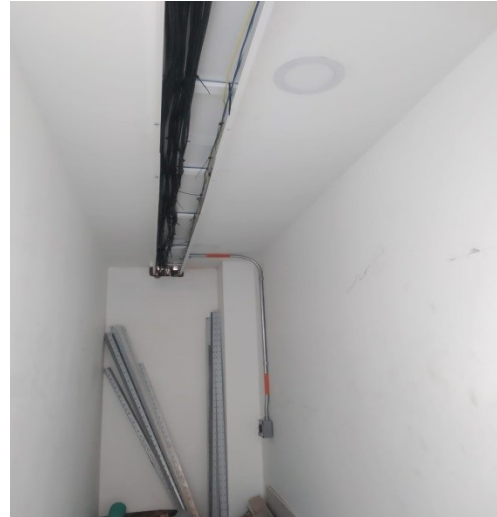
Figura 7. Instalación bandejas porta cables
