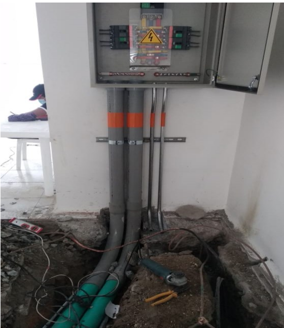
Figura 6. Instalación de tubería PVC
