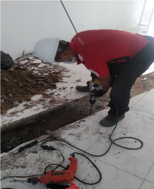
Figura 5. Instalación de acometida
