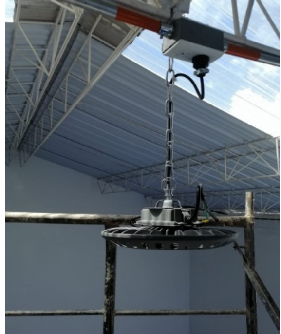
Figura 4. Instalación de luminarias tipo haiback.
