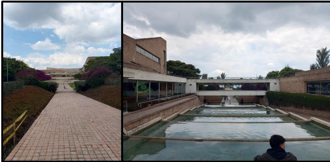
Figura 10. Paisaje Arquitectura, Parque y Biblioteca Virgilio Barco. Elaboración propia.
