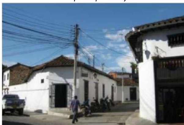
Figura 5. Tendido de red eléctrica en espacio público y aleros
