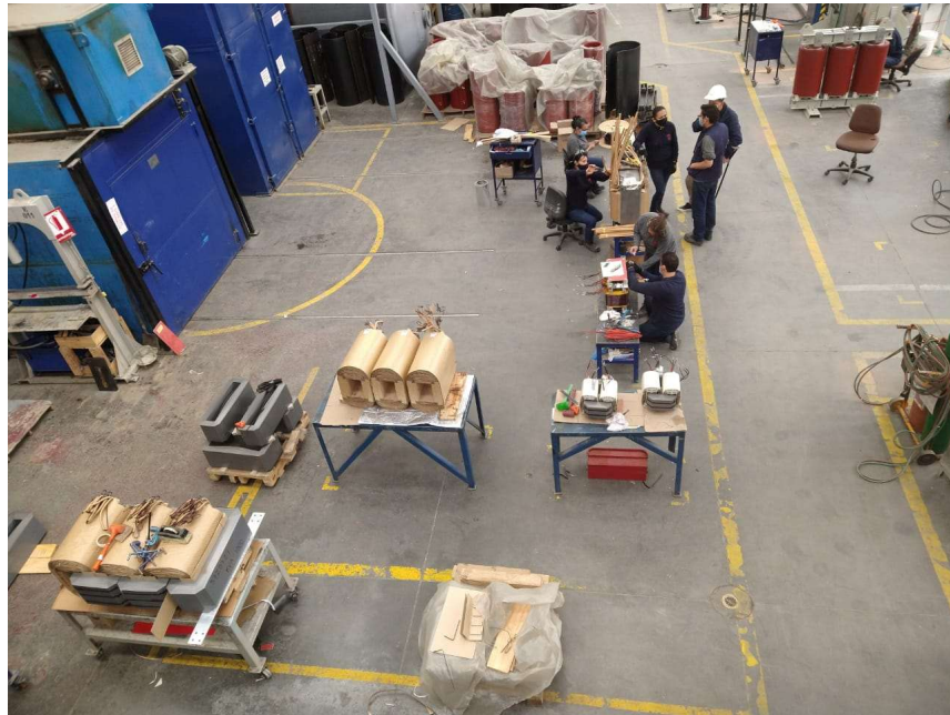
Figura 1-3 Espacio de trabajo para el ensamble de Transformadores en planta (Fuente propia).
