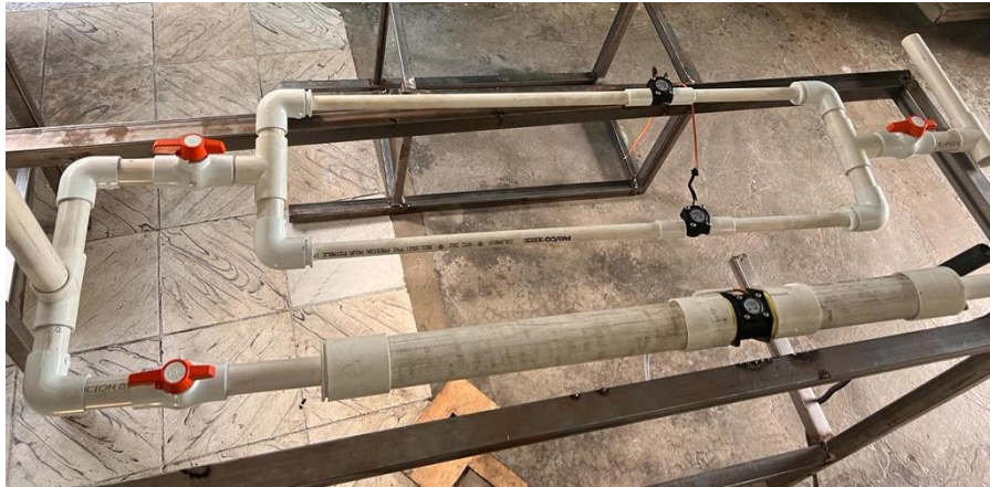
Figura 3- 11 Armado de tubería PVC con sensores
