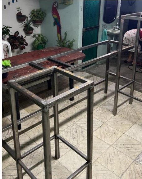
Figura 3- 10 Armado y soldado de tubería cuadrada 30x30x1.5
