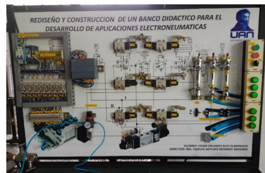
Fig. 15 Tablero electropneumático del laboratorio de Automatización (foto tomada por el autor)
