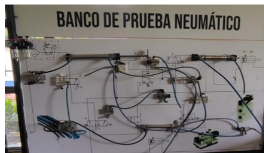
Fig. 2 Tablero neumático del laboratorio de automatización (foto tomada por el autor)
