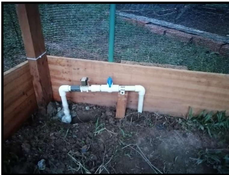
**Fig.5- 10.** conexión de la válvula de 12v para el Cultivo de sandía. [Imagen propia]
