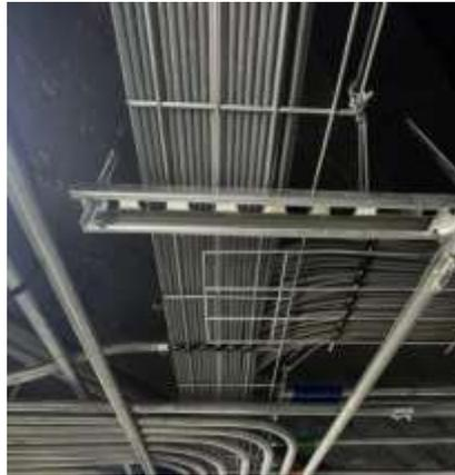
Para el cálculo del diámetro de las ducterías EMT se elaboró una tabla en la cual por cada zona o ruta se contabilizó la cantidad de puntos de red a instalar, se derrateo al 40% su capacidad y se obtuvo la medida de cada tubería utilizada (tabla 7).
