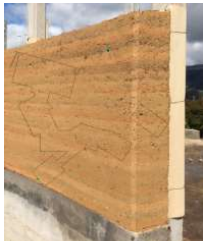
Ilustración 50. Muros en Tapia pisada
