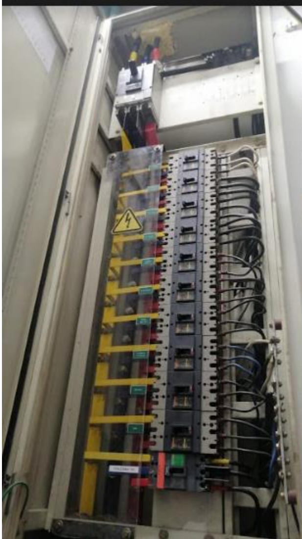
Acometida principal, circuitos ramales
