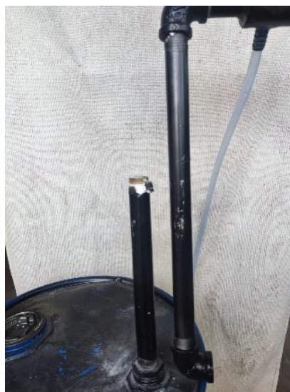
Figura 8 Tubos galvanizados; Fuente: Autores 2022
