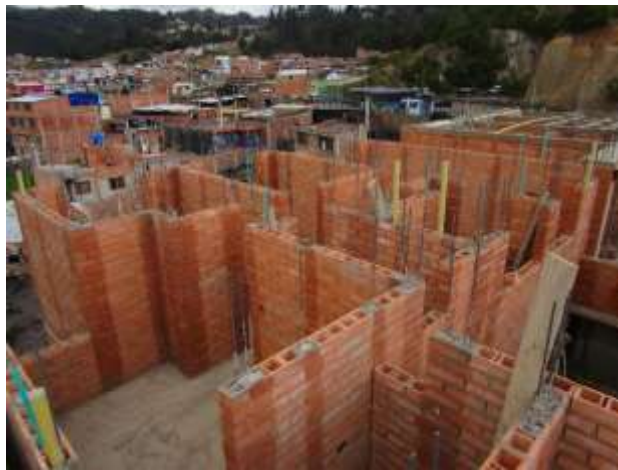
Figura 9. Mampostería del apartamento 302B.
