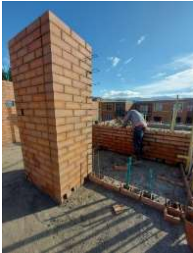
Figura 10. Mampostería del apartamento 503B.
