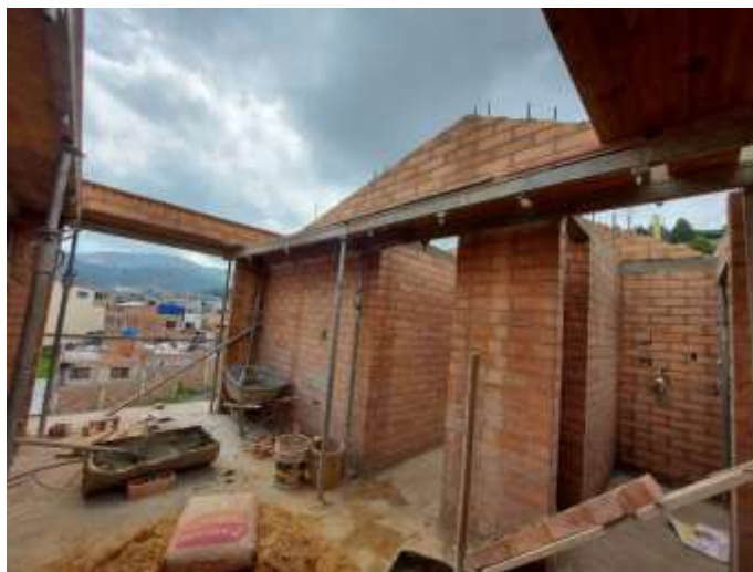
Figura 11. Cuchillas para vigas culatas de cubierta de apartamento 501B
