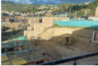
Imagen 4. Vista general del mejoramiento del suelo bloque C
