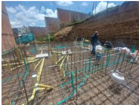
Figura 21. Placa de cimentación bloque C.
