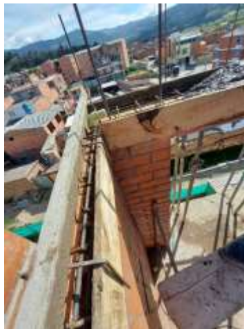
Figura 20. Vigas dinteles y vigas canales apartamento 501B.
