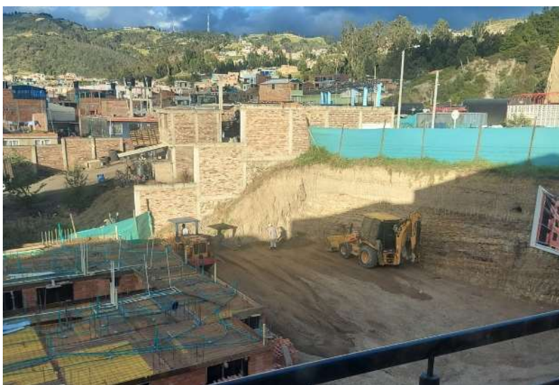
Figura 7. Mejoramiento del terreno del bloque C.
