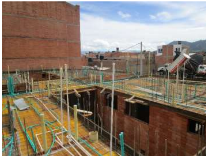
Figura 14. Extendido de red hidrosanitaria para placas de entepiso bloque B.
