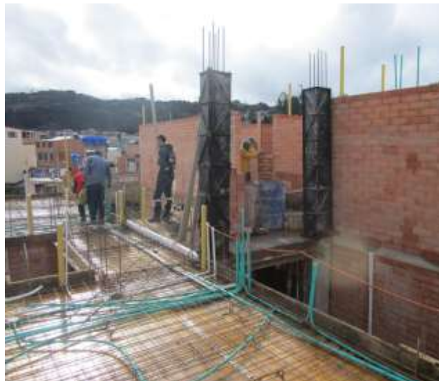
Figura 18. Instalación de formaleta punto fijo bloque B.
