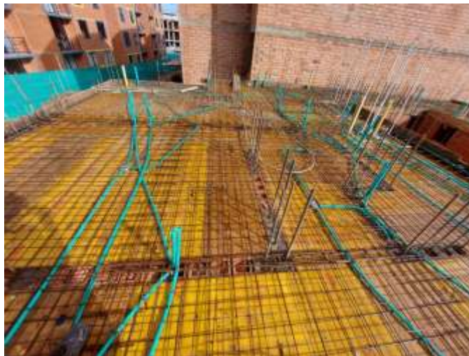
Figura 15. Vista del extendido de tubería sobre placas de entrepiso bloque B.
