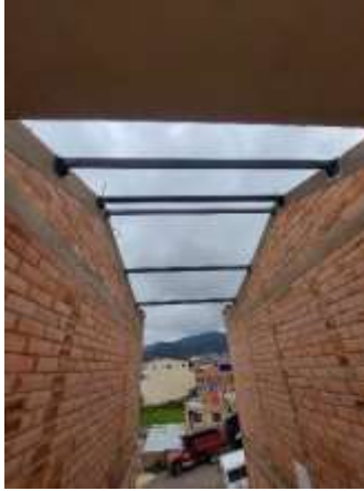
Figura 22. Correas para soporte de tejas de cubierta bloque A.
