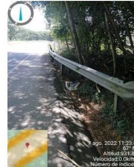
falta de mantenimiento, capta faros sin reflectividad. Según la guía de contención el terminal cola de pez no cumple.
