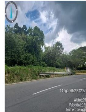
falta de mantenimiento, capta faros sin reflectividad. Según la guía de contención el terminal cola de pez no cumple.
