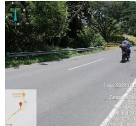
falta de mantenimiento, capta faros sin reflectividad. Según la guía de contención el terminal cola de pez no cumple y además debe ir unida a los pretilos del puente sigue sin cumplir.
