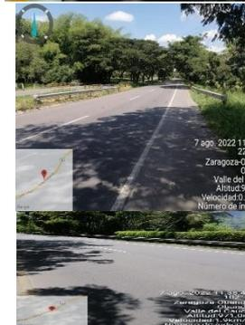
falta de mantenimiento, capta faros sin reflectividad. Según la guía de contención el terminal cola de pez no cumple.
