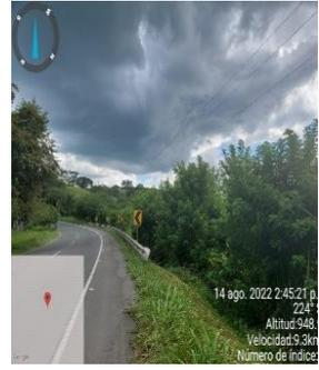
falta de mantenimiento, capta faros sin reflectividad. Según la guía de contención el terminal cola de pez no cumple además requiere más longitud al inicio de la barrera.
