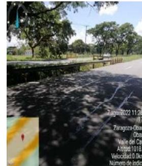
falta de mantenimiento, capta faros sin reflectividad. Según la guía de contención el terminal cola de pez no cumple y además debe ir unida a los pretiles del puente sigue sin cumplir.
