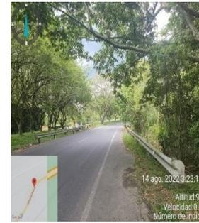
falta de mantenimiento, capta faros sin reflectividad. Según la guía de contención el terminal cola de pez no cumple.
