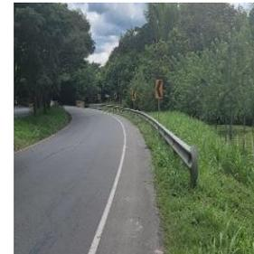
falta de mantenimiento, capta faros sin reflectividad. Según la guía de contención el terminal cola de pez no cumple.
