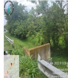
Falta de mantenimiento, capta faros sin reflectividad. La barrera no cubre la obra hidráulica. Según la guía de contención el terminal cola de pez no cumple.
