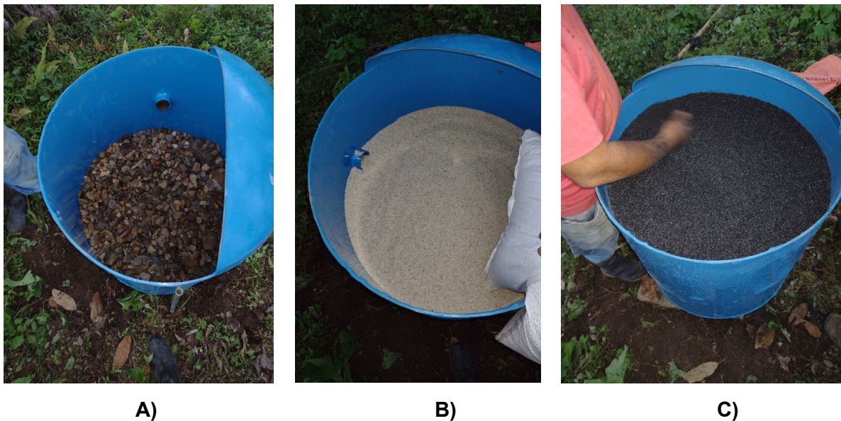
Figura 2-9: A) Piedras de tamaño grande y pequeño, B) Arena de sílice, C) Carbón activado.
