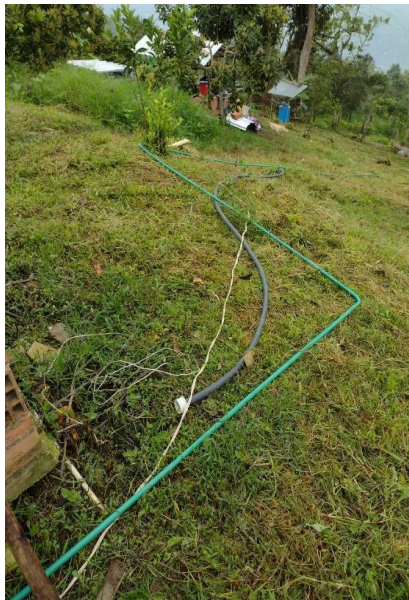
Figura 2-20: Posicionamiento de la tubería de la red eléctrica. (Fuente: los autores).
