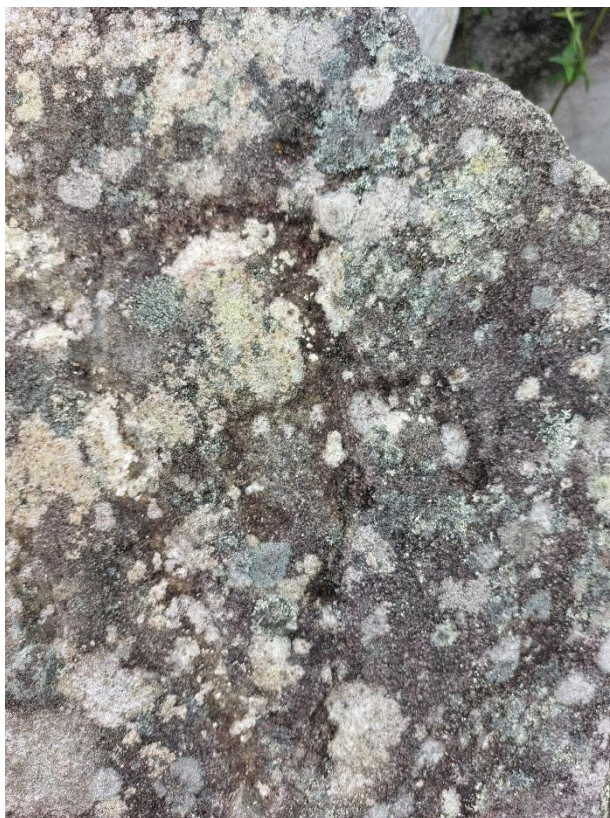
14. Vereda El Tambillo - Hongos existentes en grabados
