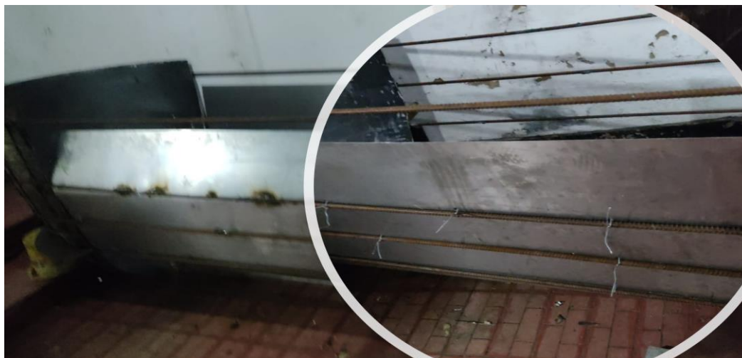
Figura 19. Fijación de la lámina a la estructura. Propia del autor.
