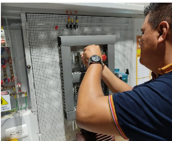
Figura 18. Instalación del tablero principal
