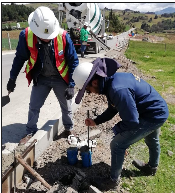
Figura 24. Toma de cilindros de concreto para laboratorio
