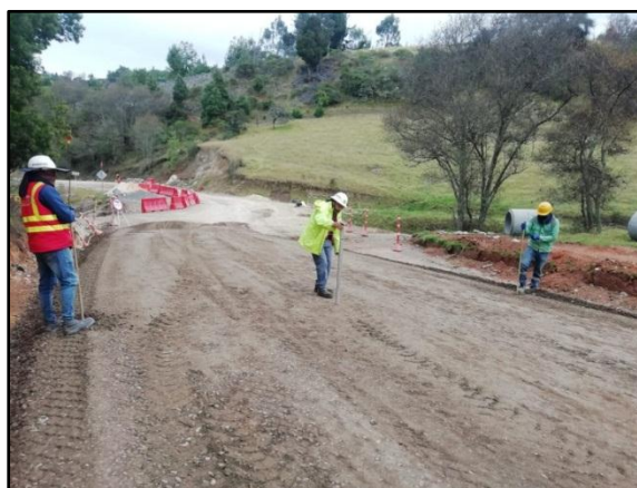
Figura 27. medición de cotas de nivel en base granular
