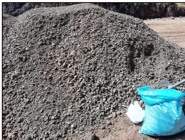
Figura 25. Toma de muestra de base granular para laboratorio
