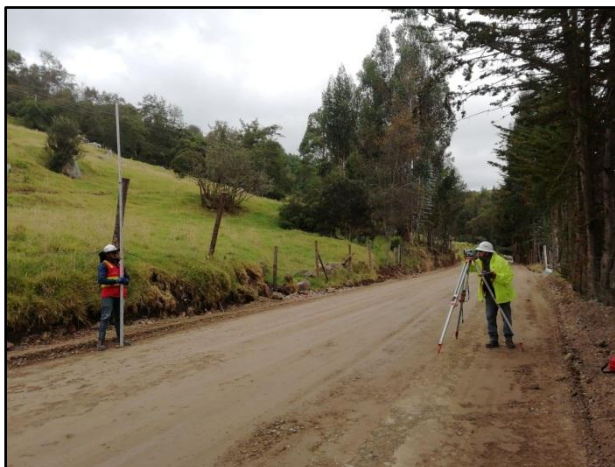
Figura 28. Medición de cotas de nivel en base granular
