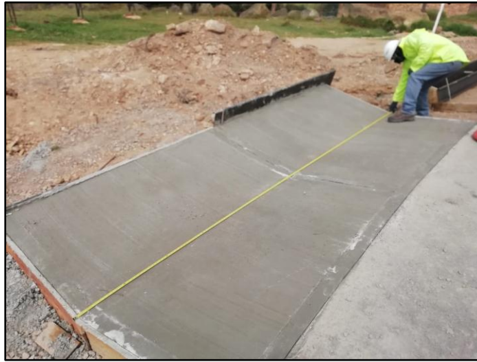
Figura 21. Medición de concreto utilizado para acceso vehicular
