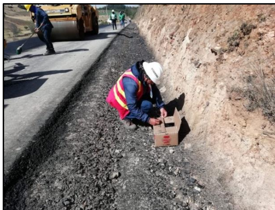
Figura 26. Toma de muestra de asfalto para laboratorio de calidad
