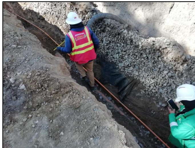
Figura 22. Toma de medición en excavación mecánica
