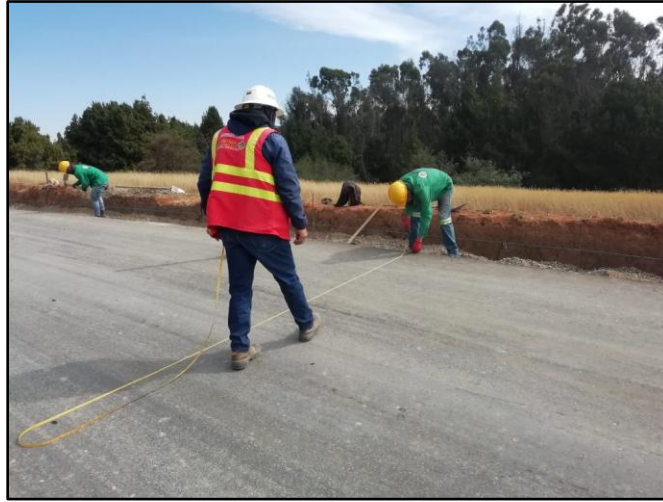
Figura 23. Medición de carpeta asfáltica
