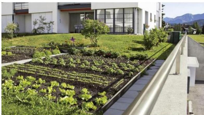
Figura 60 Cubierta intensiva. Fuente: La Cubierta Verde Como Alternativa Económica Y Sostenible A Las Cubiertas Convencionales.
