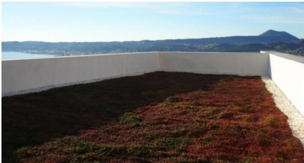
Figura 59 Cubierta extensiva. Fuente: La Cubierta Verde Como Alternativa Económica Y Sostenible A Las Cubiertas
