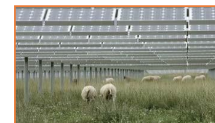
Granja solar de generación
