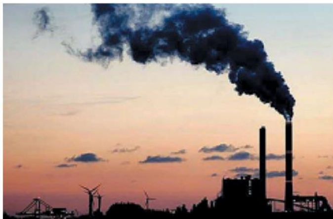
Figura 2-4: Planta de eliminación de residuos (Incineradora).
