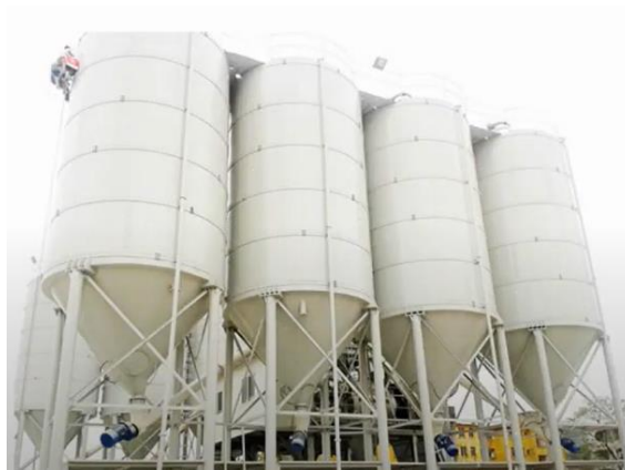
Figura 13 Panorama de silos de almacenamiento del producto final
