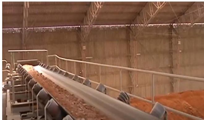
Figura 6 Bandas transportadoras internas en el proceso de Prehogenización
