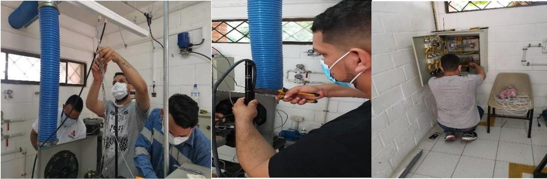
**Figura 17** – Organización de cableado a tablero eléctrico y sensores instalados al motor.
