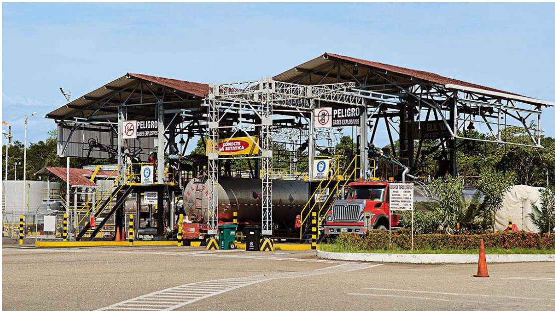
Fig. 2 área de cargue
