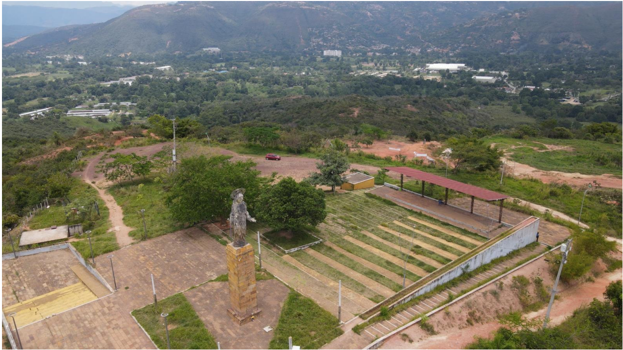
Figura 55. Fotografías Panorámicas tomadas de un Drone, Cerro de la Cantera, Piedecuesta – Santander. Extraído: Elaboración propia.
