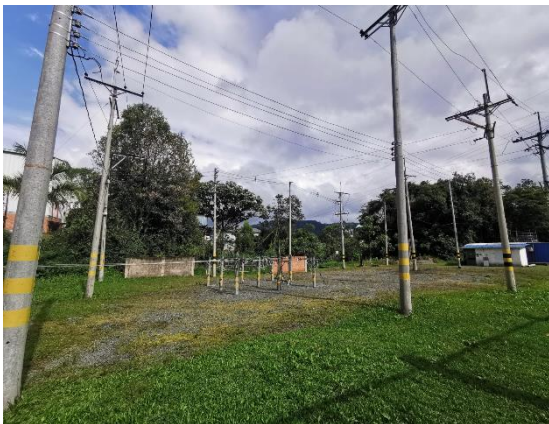
Fig 3. (b) Postes de 12m. Campo de entrenamiento.
