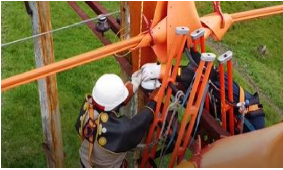
fig. 4 (b): Cambio Aislador Tipo Pin. Fuente: Elaboración Propia
