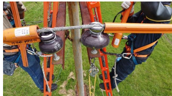
Fig 4. (a) Cambio de Aislador Tipo Pin.
