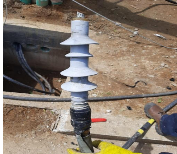
fig. 8: Terminal premoldeado Fuente: Elaboración Propia.
