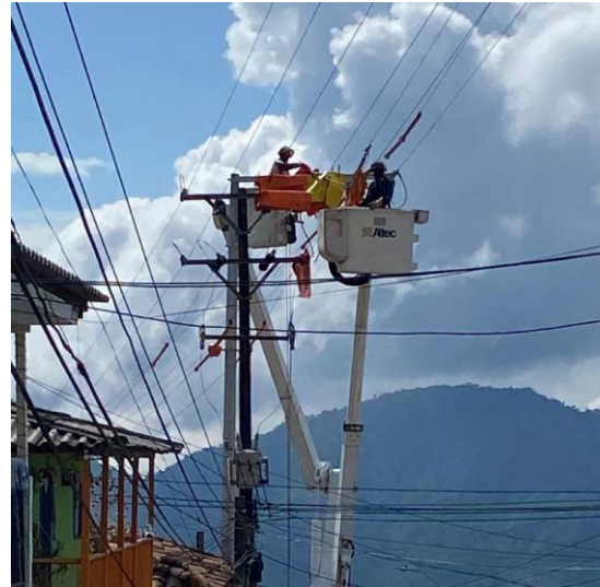
fig.5: Cambio Disposición Suspensión a Retención. Fuente: Elaboración Propia.
