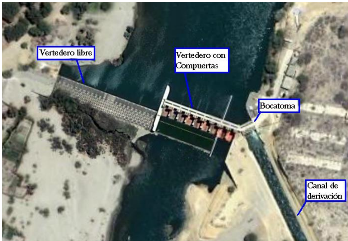
Figura 1-4 Canal de derivación
