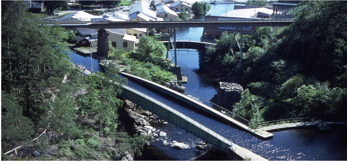
Figura 1-3 Conducción por gravedad
