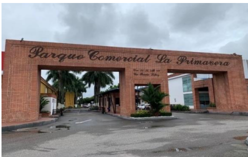
Figura 3 Fachada parque Comercial la Primavera
