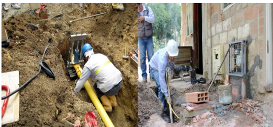
Figura 4. Sistema de tubería de media presión-red secundaria (Polietileno), [6].
