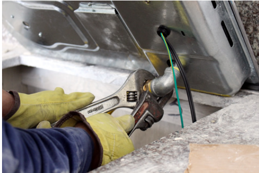
Figura 8. Conexión a gasodomésticos, [6].
