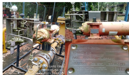
Figura 13. Sistema hidráulico de parada de emergencia Pressure Guard Bettis
