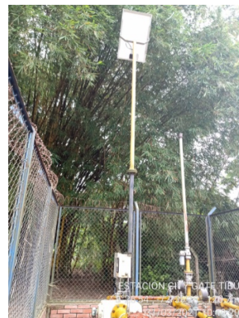
Figura 22. Sistema solar City Gate Tibú.
