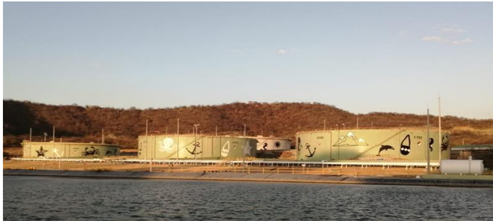
Figura 7: Tanques de almacenamiento de hidrocarburos Terminal Pozos Colorados.
