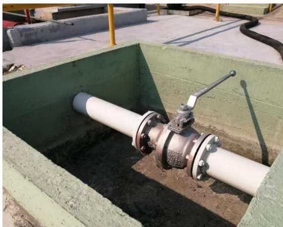
Figura 19: Válvula de salida del producto hacia el tanque de recuperación.
