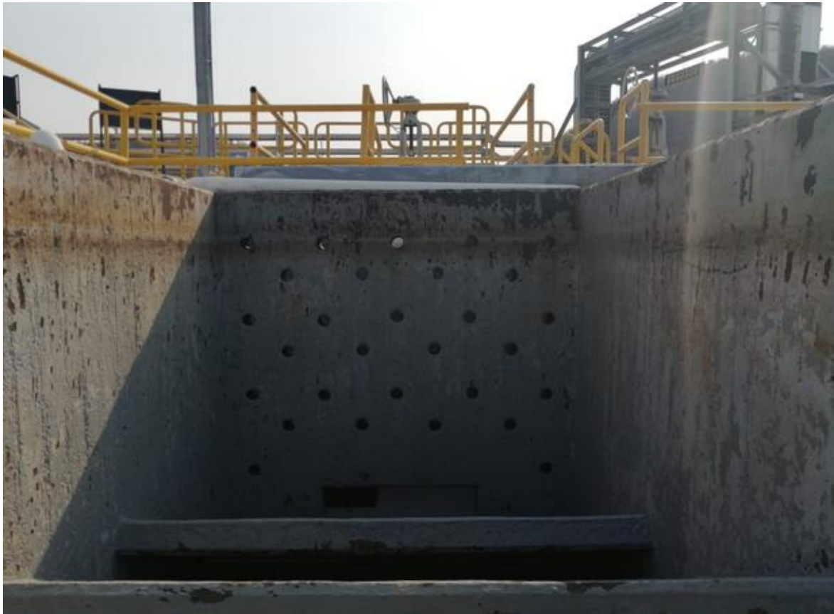
Figura 17: Pared de separación de lodos.
