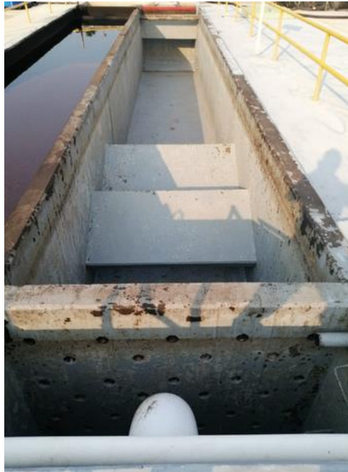
Figura 18: Vista lateral del Separador API (Trampas de lodos, pared separadora de sólidos y flauta recolectora)
