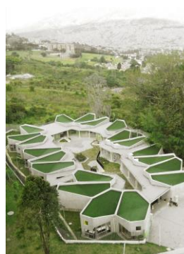
Ilustración 83: Fuente (Plan B Arquitectos, Archdaily, 2011)
