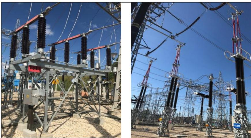
(A) Seccionador de apertura central      (B) Seccionador pantografo
