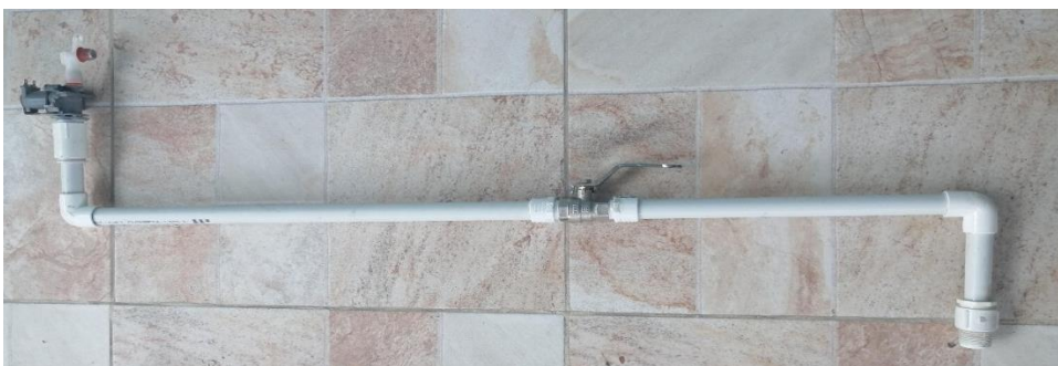
Figura 61 Acometida hidráulica
