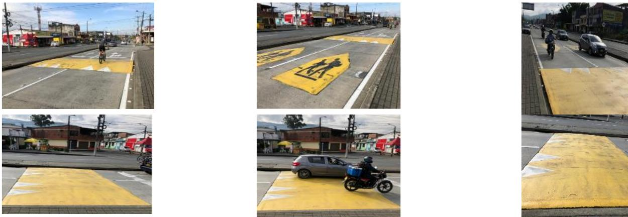
Figura 27. Muestra aplicada con llana en Dosquebradas (Playa Rica)
