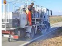
Máquina demarcadora hidráulica
