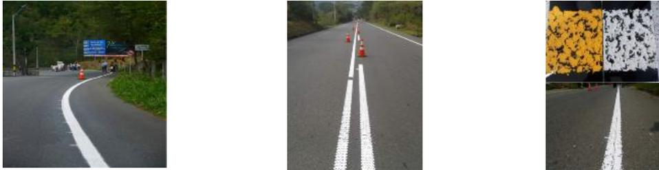
Figura 26. Aplicación con maquina extrusión muestra pintura en Antioquia (Pintuco)
