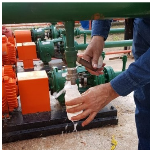
Figura 30. Toma de muestra no. 1. Succión bomba suministro agua inyección CT2. Fuente: Autores
