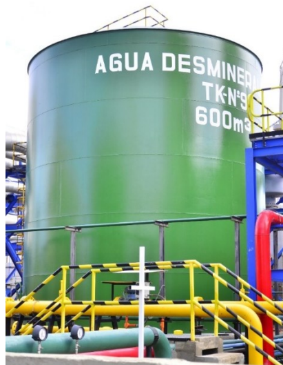
Figura 12. Tanque de agua desmineralizada no. 9. Fuente: Autores
