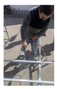
Figura 31. Pintura de láminas de madera que sujetan intercambiador y electrobomba
