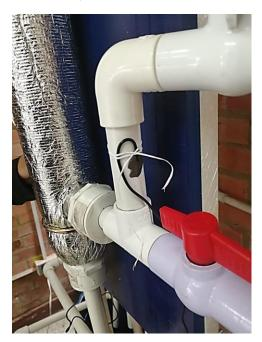
Tabla 10. Accesorios para conexión hidráulica del intercambiador
