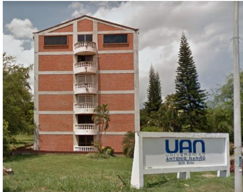
Figura 3-2: Vista lateral de la edificación bloque A
