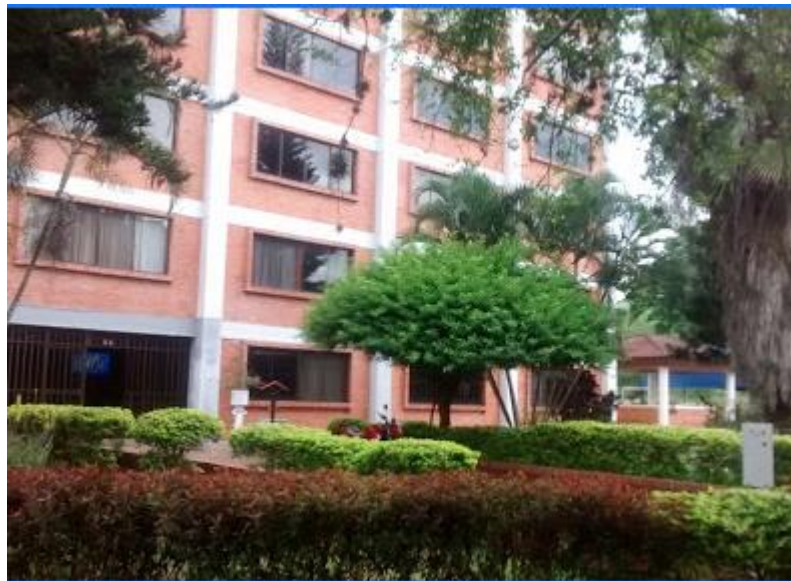
Figura 3-3: Vista frontal de la edificación bloque A
