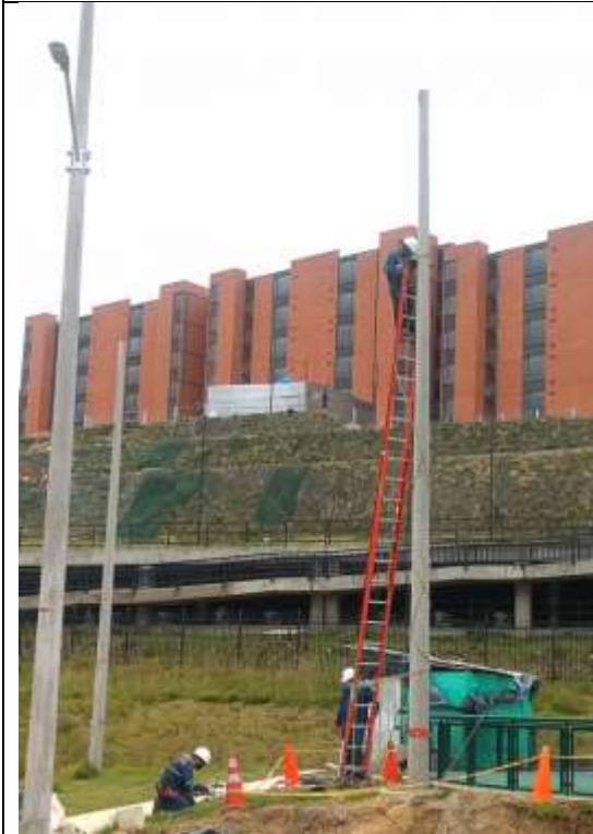
Maniobra de instalación de luminarias
