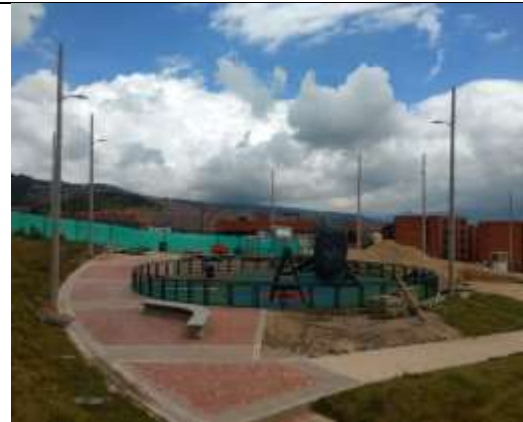
Luminarias en zona de Juegos N°2
