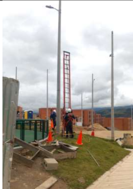
Maniobra de instalación de luminarias
