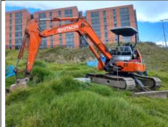
Retroexcavadora realizando apertura de zanjas para la canalización e instalación de ductos PVC.
