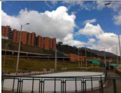
Luminarias en pista de patinaje
