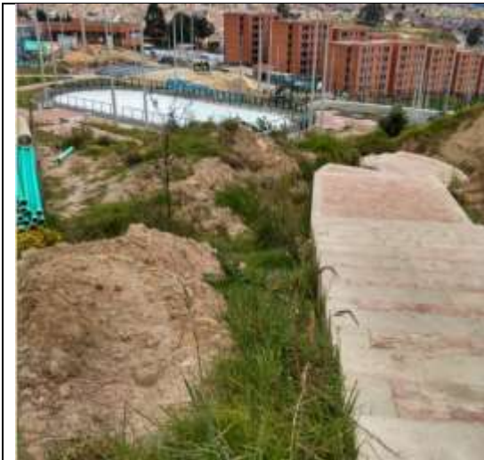
Canalización pista de trote
