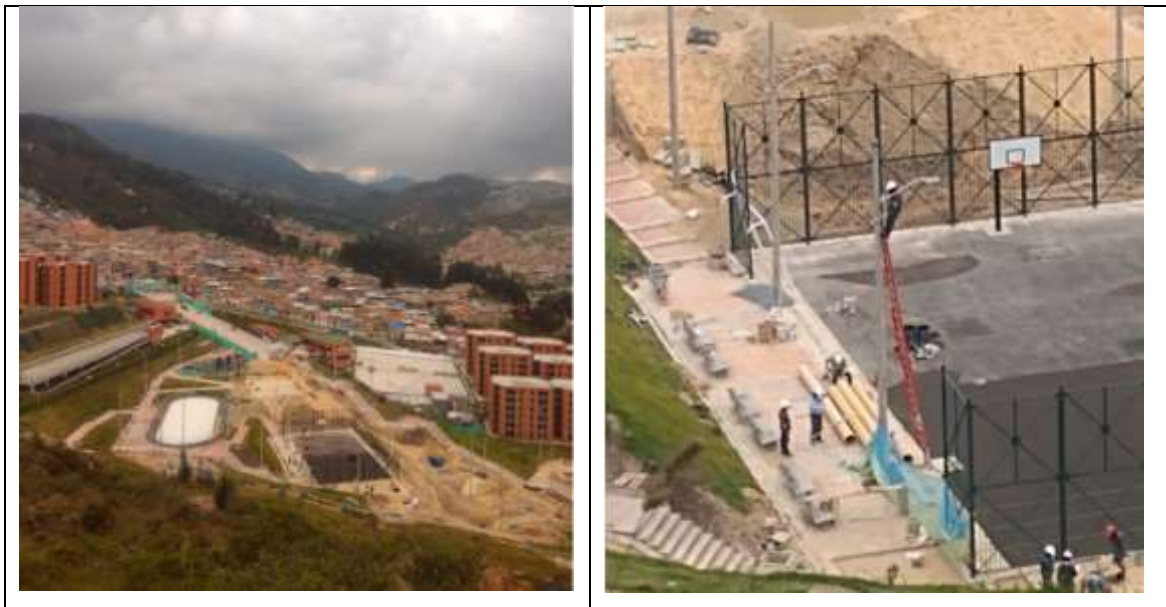
Figura 9: Avance de obra a corte del 1/09/2020 Alameda y escenarios deportivos
