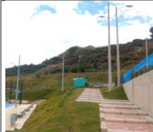
Luminarias en sendero Caballeras
