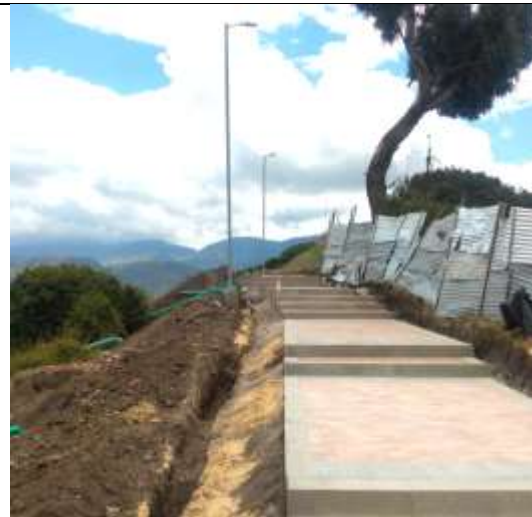
Canalización pista de trote
