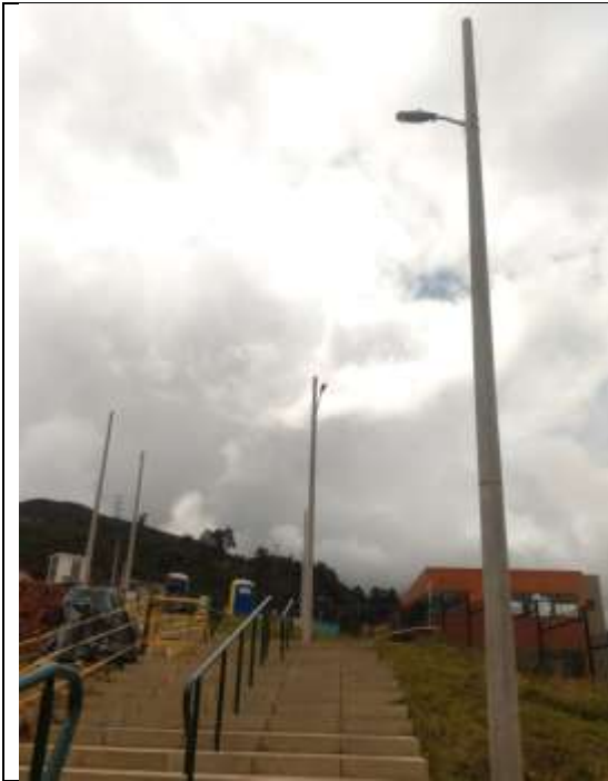
Luminarias instaladas en sendero cental V-9
