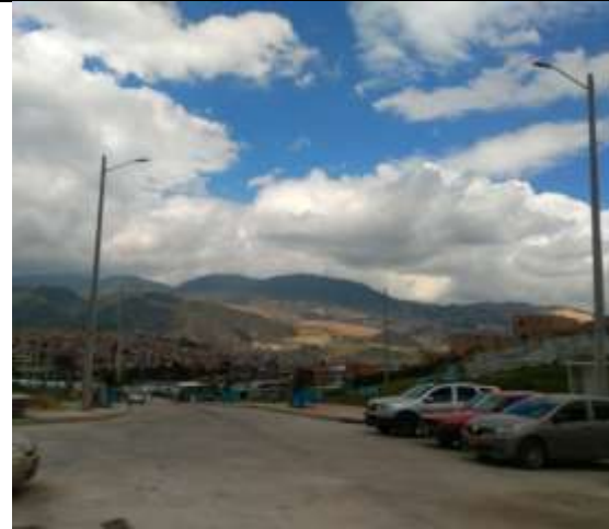
Luminarias en via Oriental V-7
