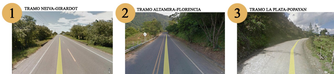
Ilustración 5 Tramos viales del Huila
