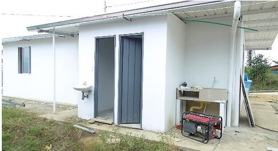
Figura 1. Vista de acceso al baño. Fuente: Alcaldía Municipal de Miranda, Cauca.
