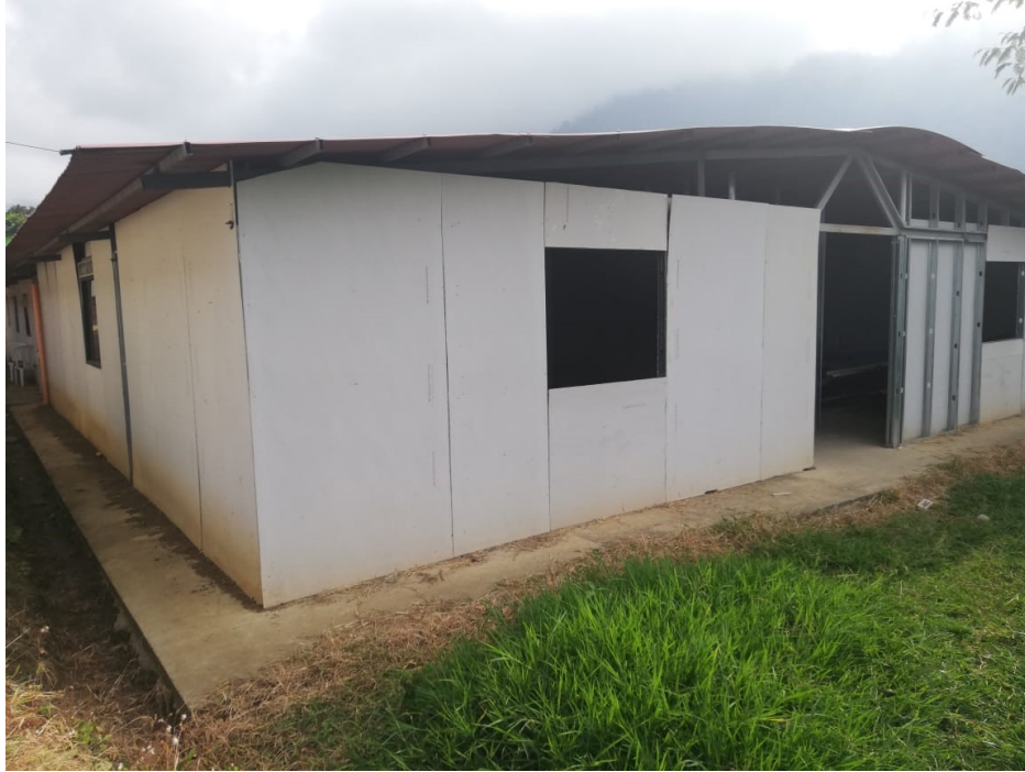
Figura 67. Estado actual de viviendas. Fuente: Propia (2020).
