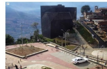
Figura 2. Panorámica Parque Biblioteca España recién construido.
