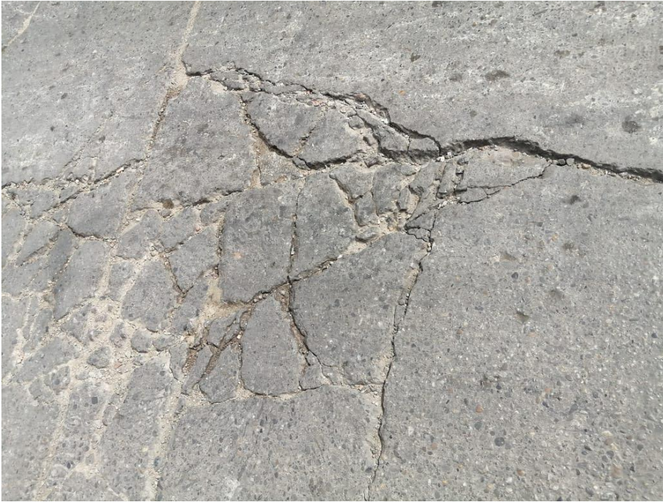
Figura 18 Fracturación múltiple
