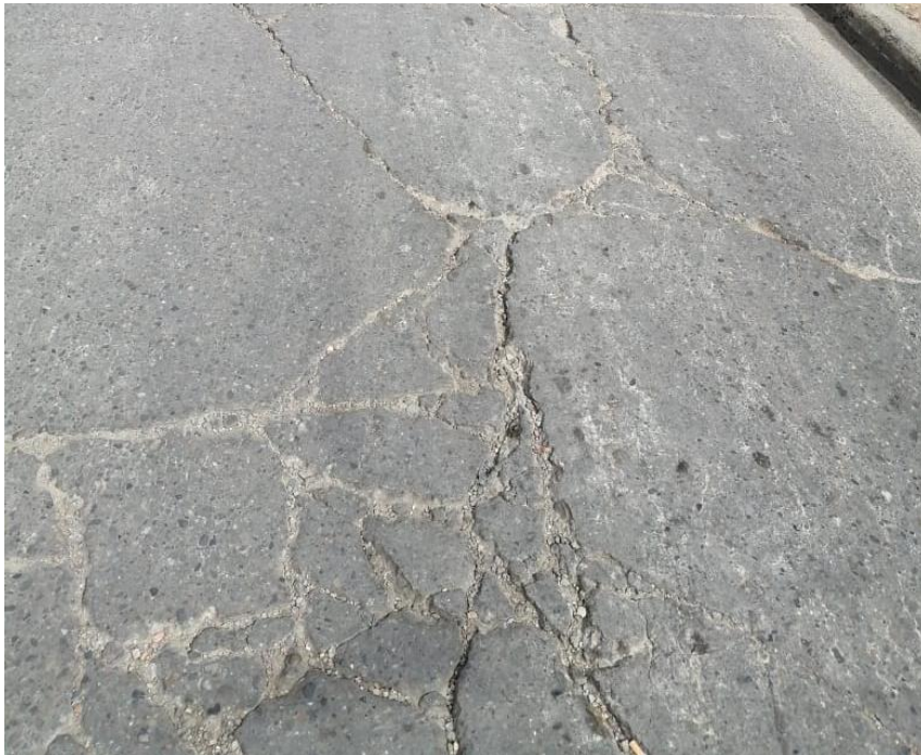
Figura 17 Fracturación múltiple
