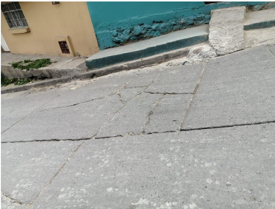
Figura 23 Fracturación múltiple
