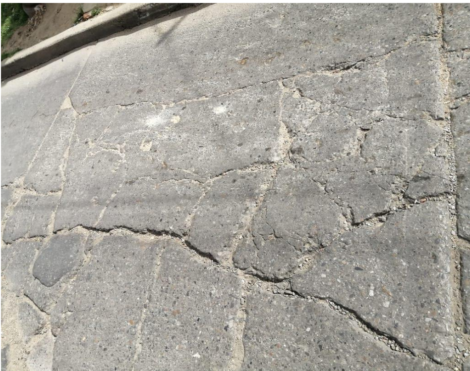
Figura 15 Fracturación Múltiple
