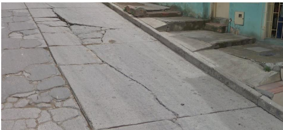
Figura 32 Hundimiento y GL
