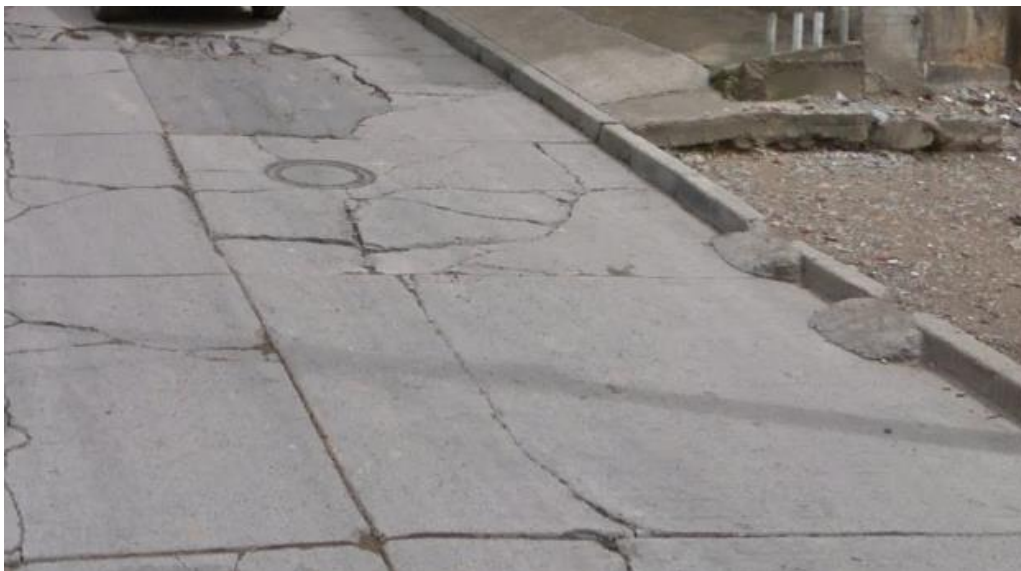
Figura 32 Hundimiento y GL
