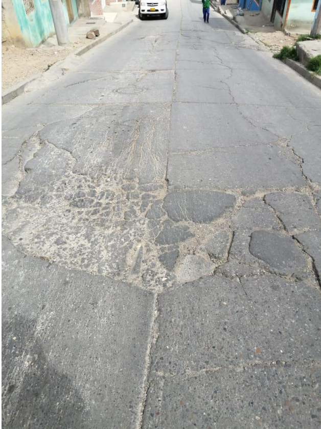
Figura 17 Fracturación múltiple
